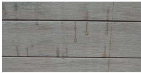
Fleckenbildung durch von Regen angelöste Partikel
