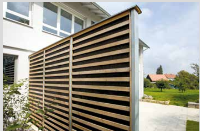
Verblendungen: Kiefer Halbhölzer senkrecht 4,9 cm | Lärche Halbhölzer senkrecht 4,9 cm | Lärche Leistenprofil senkrecht 5,6 cm | Lärche Rautenprofil waagrecht 5,5 cm ca. Lattenabstand:
