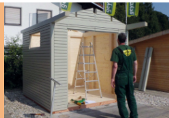
Einsetzen der fertig montierten Wand- und Giebelelemente
