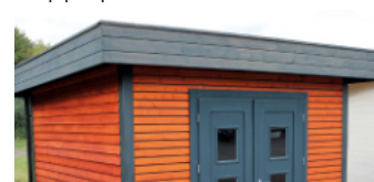
Flachdach (mit Dachüberstand)
