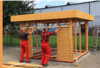
Anbringen der Rhombusschalung
