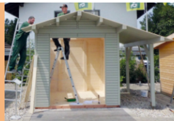
Erstellung der Dachschalung
