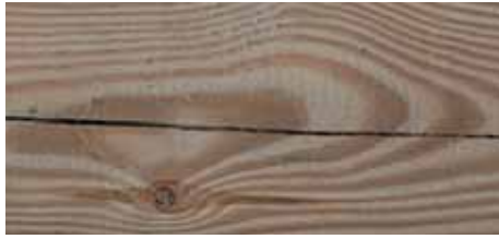
Spannungsrisse durch die Holz Trocknung
