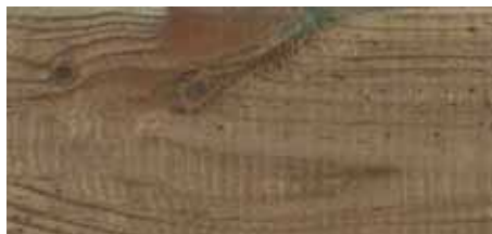
Raue Stellen auf der Holzoberfläche
