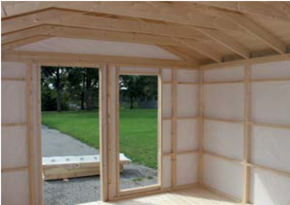
Innenansicht, Wände mit Windschutzfolie
