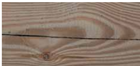
Spannungsrisse durch die Holz-trocknung
