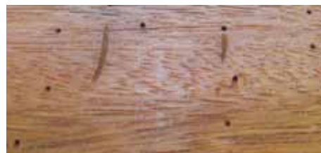
„Pinholes“ bei überseeischen Harthölzern
