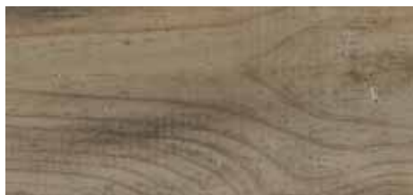
Stockflecken und leichter Schimmelbefall
